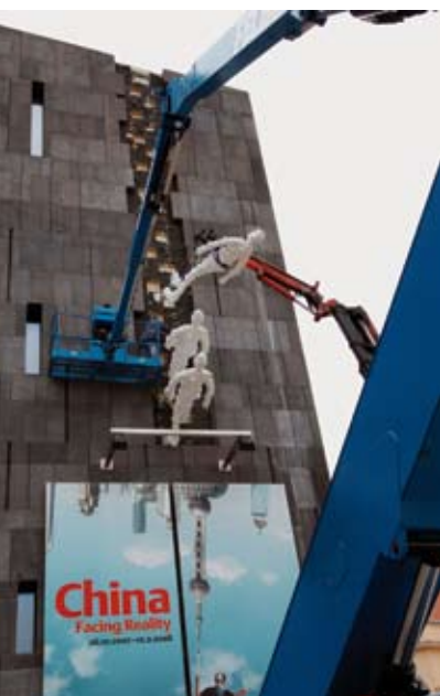
Aufbau der Fassadeninstallation The Two Ways von Wan Jian Wei
