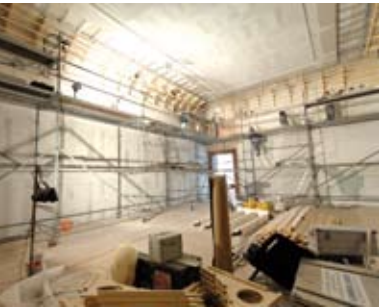
Baustelle Unteres Belvedere
