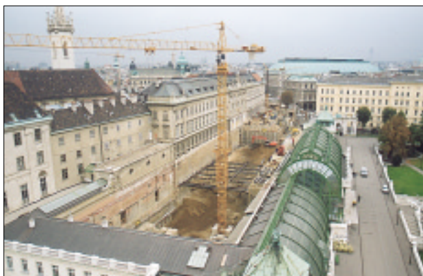
Blick auf die Baugrube in der Studiengebäude, Tiefspeicher und Wechselausstellungshalle entstehen werden
