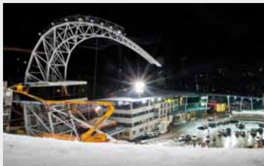
*Der Skygate (Foto), Schladmings neues Wahrzeichen, ist das weithin sichtbare Symbol der Ski-WM 2013: in den Himmel ragende 135 Tonnen Stahl, 35 Meter tief in der Erde verankert, um die Pendelbewegungen bei Wind auf maximal 50 Zentimeter auszugleichen. Bei der WM wird das mächtige Himmelstor mit teilverspiegeltem Thermoglas überzogen und von innen magisch beleuchtet sein.*
