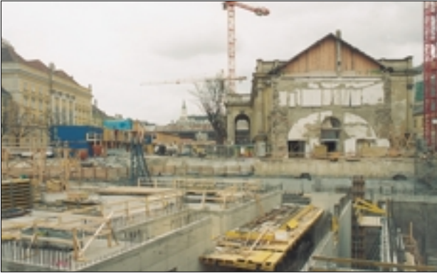
Museumsquartier Wien, Baustelle
