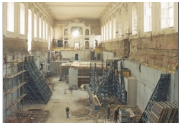
Museumsquartier Wien, Baustelle
